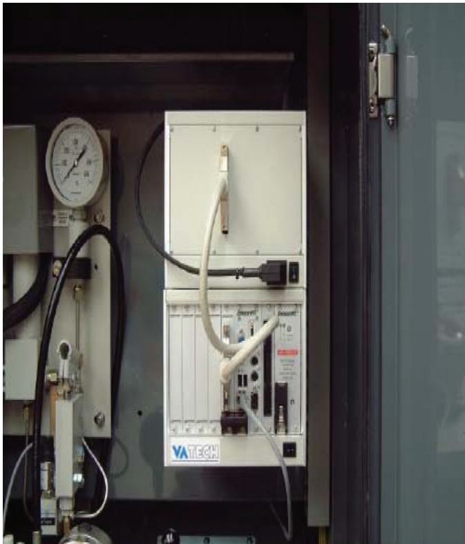
Hình 5. Tủ kiểm tra máy cắt CBM
